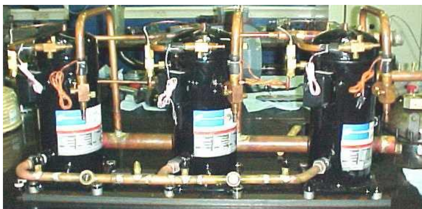
Рис.2: Параллельная работа спиральных компрессоров
