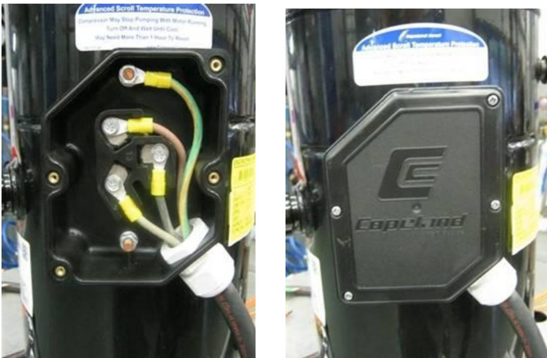
Рис. 11: Правильное электрическое подключение клеммной коробки IP54 с помощью кабельных муфт
