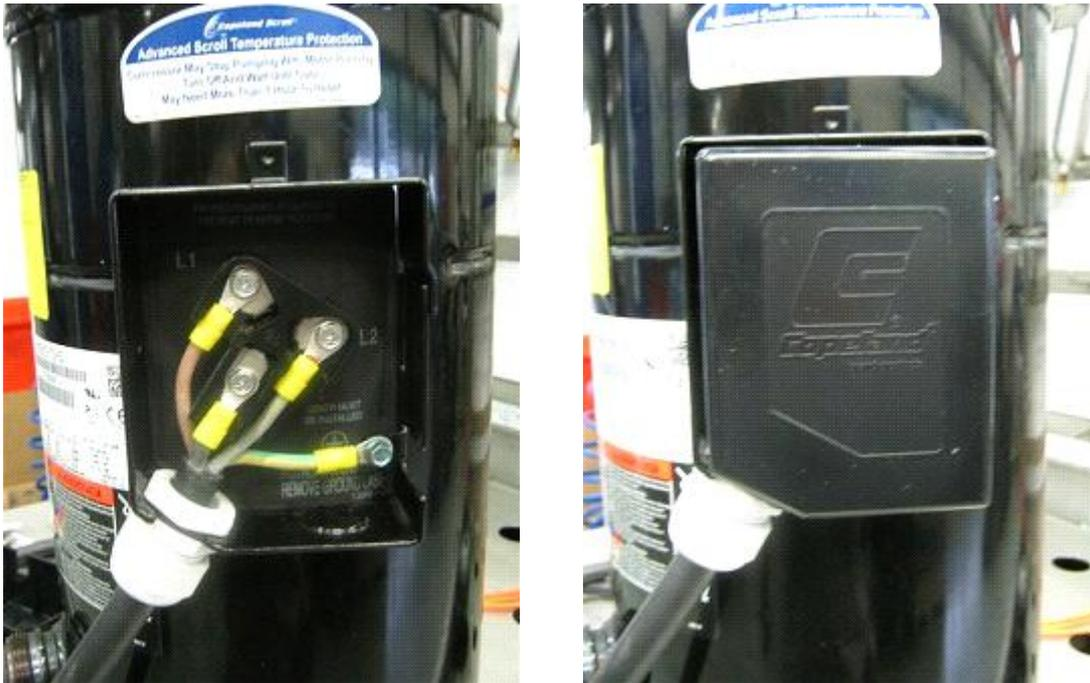
Рис. 10: Правильное электрическое подключение клеммной коробки IP21 с помощью кабельных муфт
